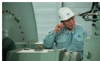
オペレーション&メンテナンス作業
