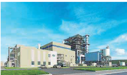
福島いわきバイオマス発電所 (112MW)
